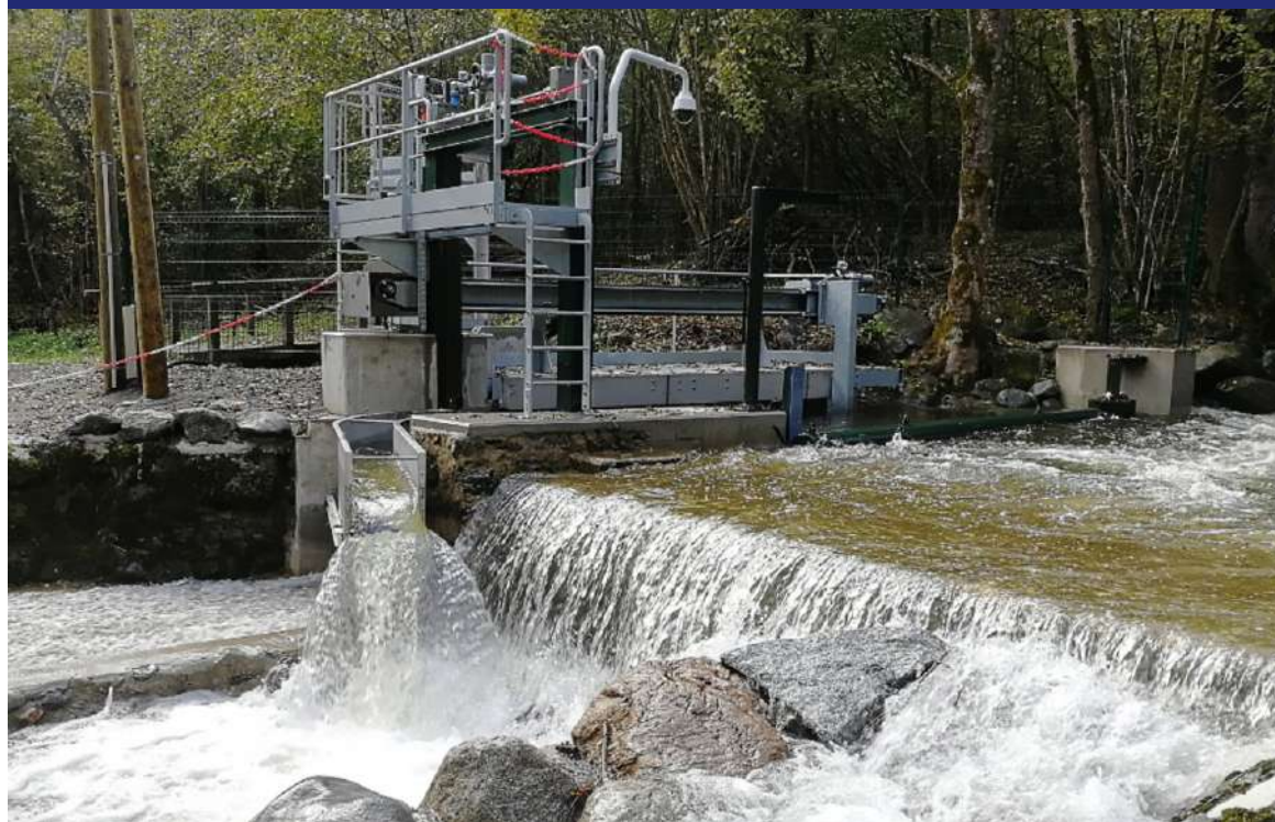
Prise d'eau de la centrale hydroélectrique d'Usson (11)
