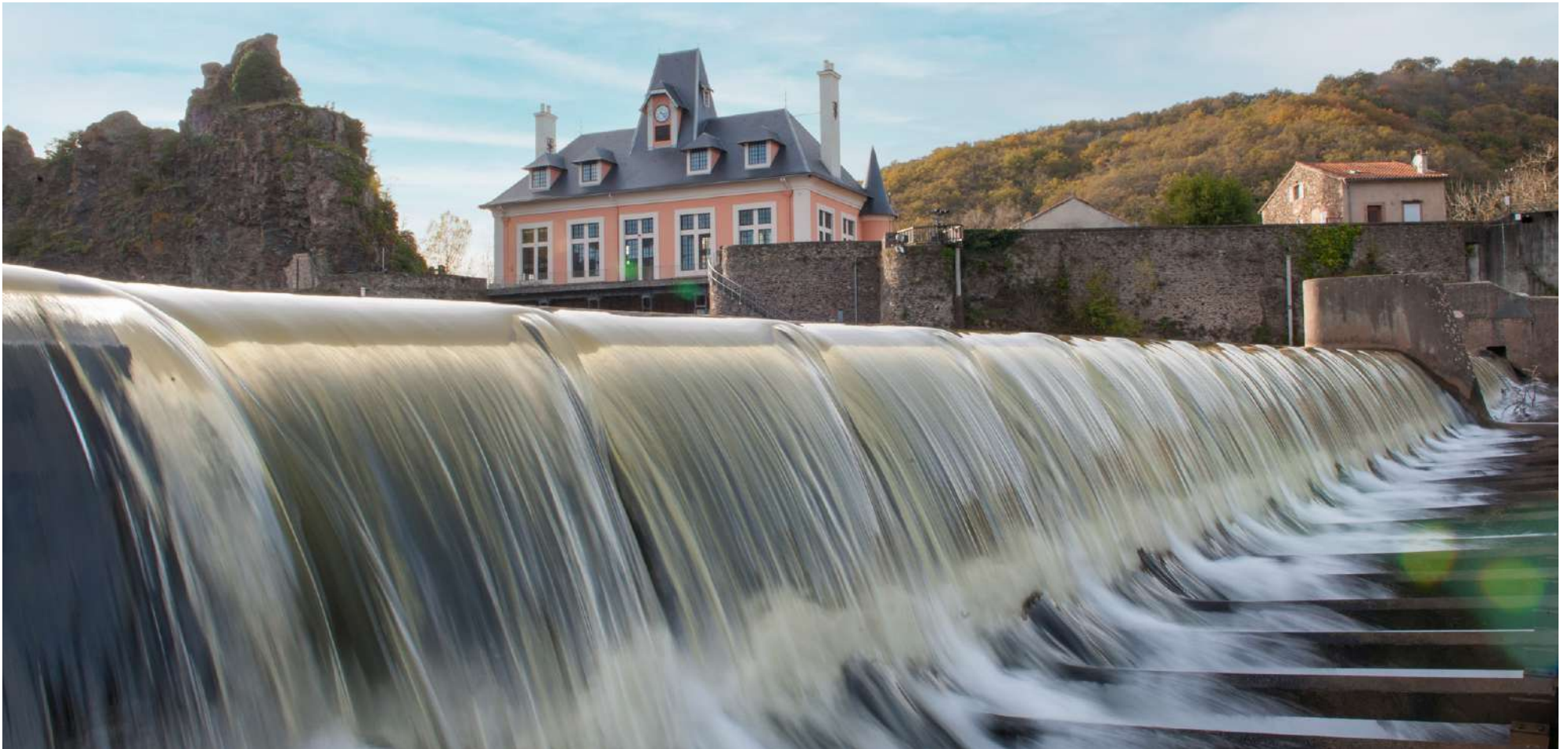
Centrale hydroélectrique d'Ambialet (81)
